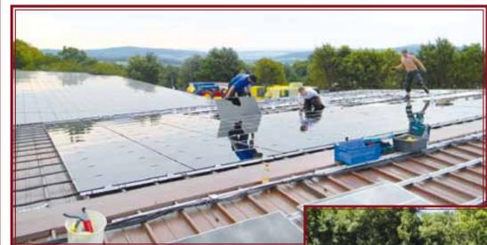
die wir auf unserer größten Dachfläche installiert haben. Diese haben wir in der nächsten Ausbaustufe erweitert, so dass die gesamte Leistungskapazität 153,9 kWp erreicht. Mit diesem Sonnenkraftwerk können pro Jahr rund 90 Tonnen Kohlendioxid-Emissionen (CO<sub>2</sub>) eingespart werden.
